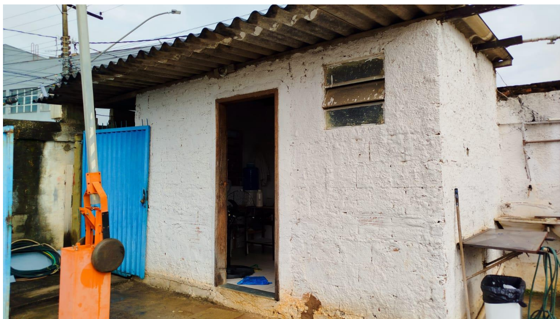
Foto 5 - Construção a ser demolida
